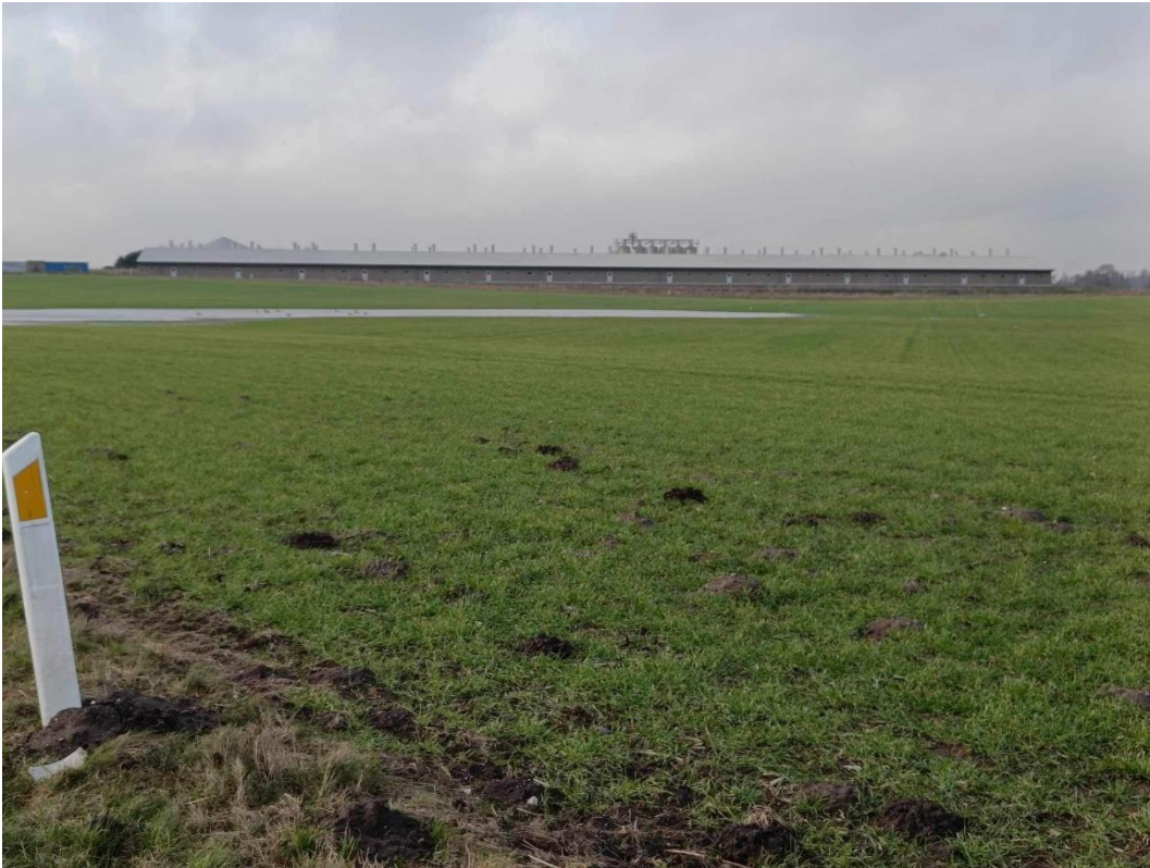
Billede 4. Anlægget set fra øst. 200 m lang mur, som er hævet 3 m over terræn i den nordlige ende. Flankeret af 2 gylletanke, der øger murens længde med omtrent 50 m. Dertil 8 fodersiloer, der rager yderligere 2,3 m op over kip, samt de 58 skorstene.
